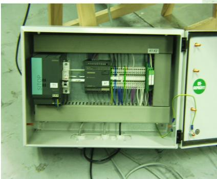
Mit sehr geringem Aufwand an Steuerungstechnik z.B. mit einer LOGO-Steuerung können Sie als Einzel- oder Blockabzug, Start- Stopp und Einzelansteuerung vornehmen.
